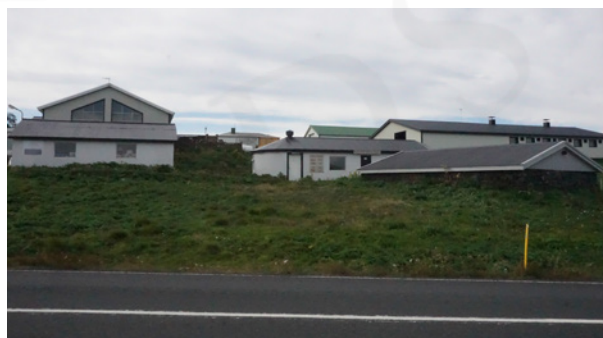
Samkvæmt túnakorti frá 1919 stóðu Miðhús milli tveggja bygginga sem eru notuð í tengslum við framleiðslu á reykum silungi. Horft til suðurs.
