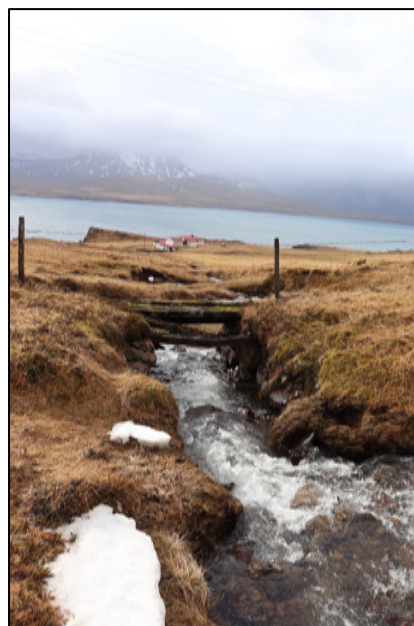
Mynd 17. Brú 2755-9. Horft til S í átt að Lækjamótum.
