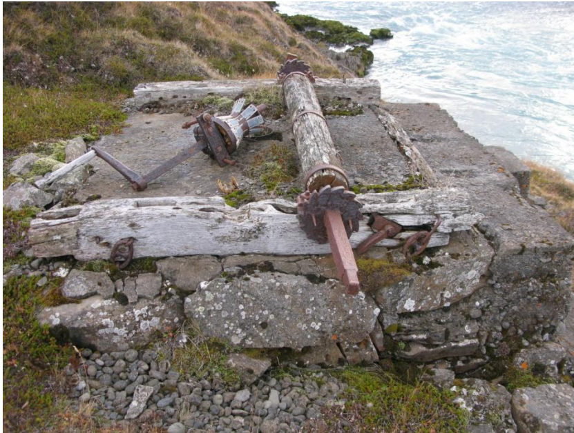
Mynd 12. Steyptur stöpull Flatatungukláfsins.
