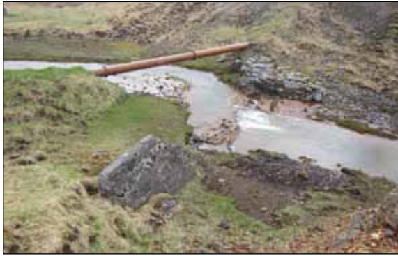
Stífla 038 hefur að hluta til verið brotin niður. Horft til suðurs.
