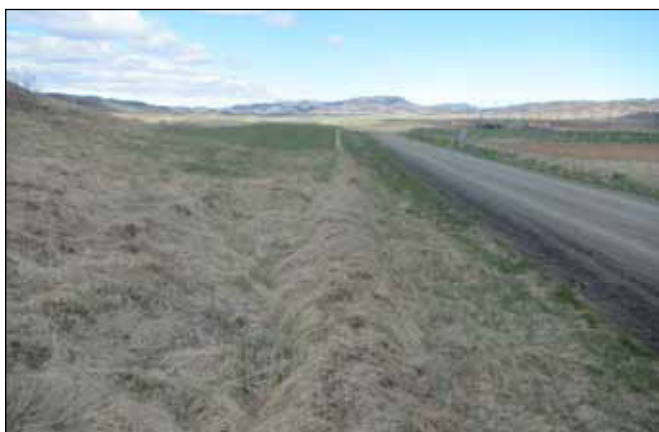
Túngarður 013, horft til norðausturs
